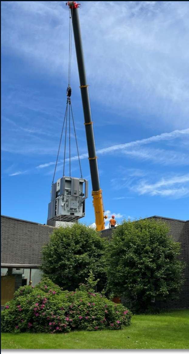
Ovnsrom: fjernet takplater og heiste inn ovn og røykgasskanal via tak!
