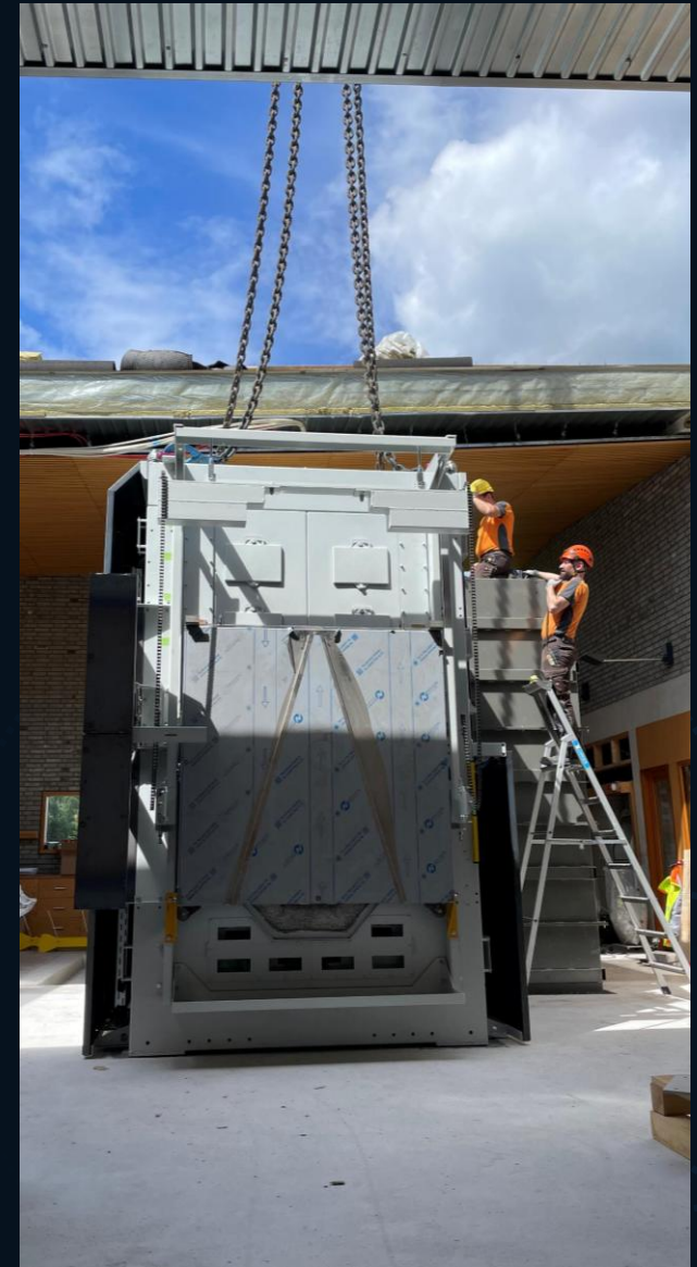
Ovnsrom: fjernet takplater og heiste inn ovn og røykgasskanal via tak!
