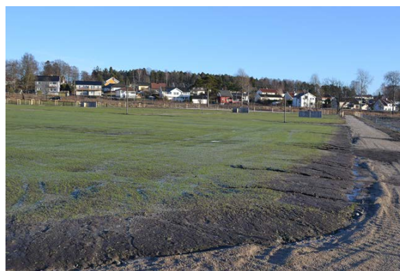
Figur 8. Hafslund gravplass etter opparbeiding av nytt felt. Til høyre vises utslag av erosjon i topplaget etter regn i vinterperioden med frosne lag dypere ned. Foto: Trond Knapp Haraldsen.
