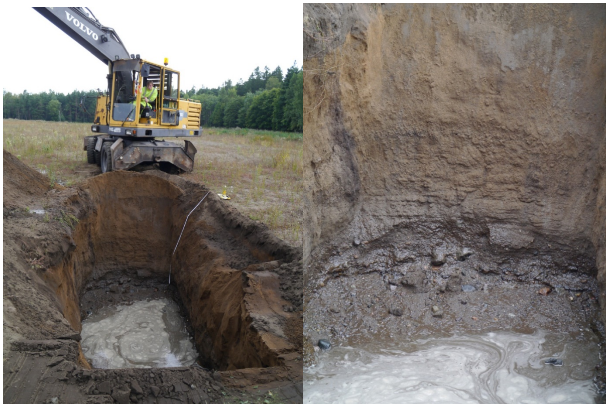
Figur 5: Jordprofil på Høyenhall, Jeløy. God drenering i øvre 1,5 m, og vannutslag lenger nede. Foto: Privat.
