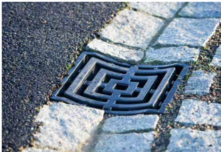
Selv slukene må være fine, her rennerist fra GH-form. Den er blant annet benyttet på Kausland gravplass i Øygarden. (Foto: Pål Hoff)
